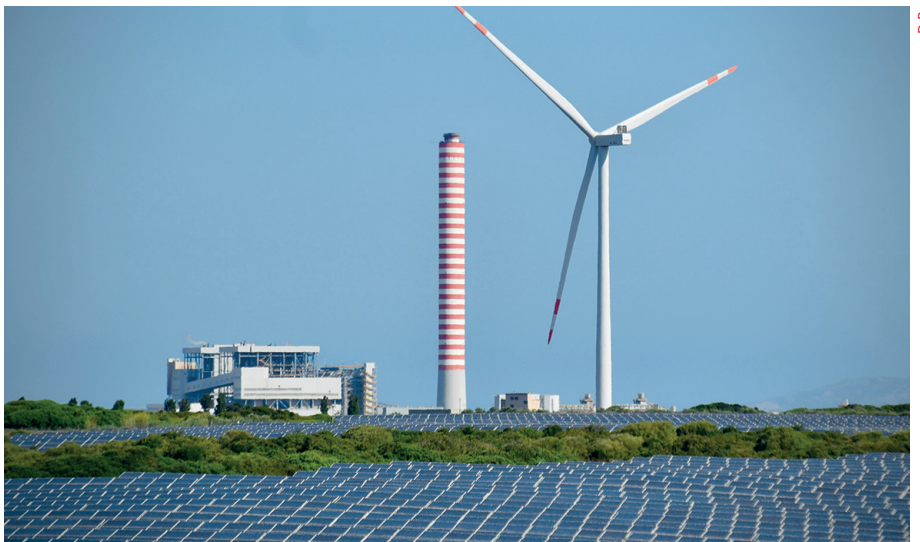
▲ Centrale éolienne et panneaux solaires. La gestion privée des énergies renouvelables va coûter cher à EDF et au contribuable.
